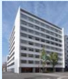
A-53 KDX博多南ビル
